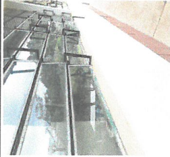
Foto 5: Vista de las paredes de las aulas, se remozará con pintura de agua y el zócano se pinta con pintura de aceite.
